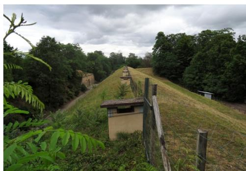
En 2006, la végétation a envahi les toitures, il faut revoir l'étanchéité. La couverture de tuiles est démontée, à la place on pose une géomembrane de protection. Une nouvelle couverture de terre végétalisée recouvre le casernement.
