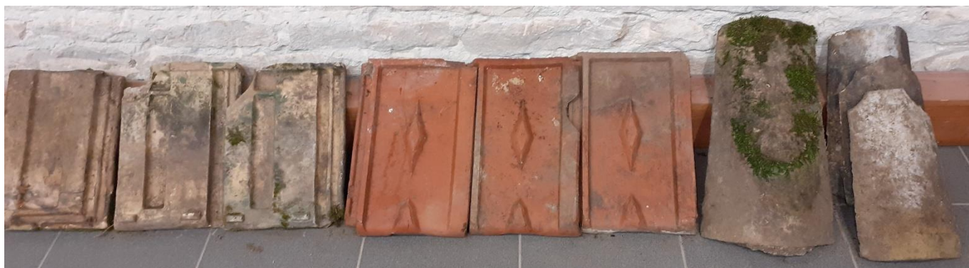
Tuiles trouvées lors des travaux d'étanchéité de la toiture en 2023
