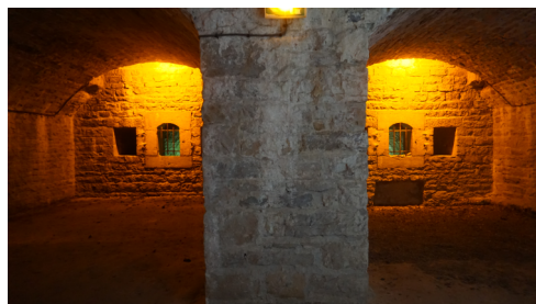
Les deux chambres de tir
